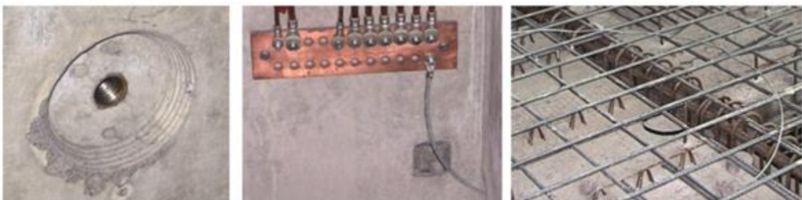
Mynd 27 - Dæmi um tengistað í burðarvirki, spennujöfnunarklemmu og stálvírsbugðu í plötu.
